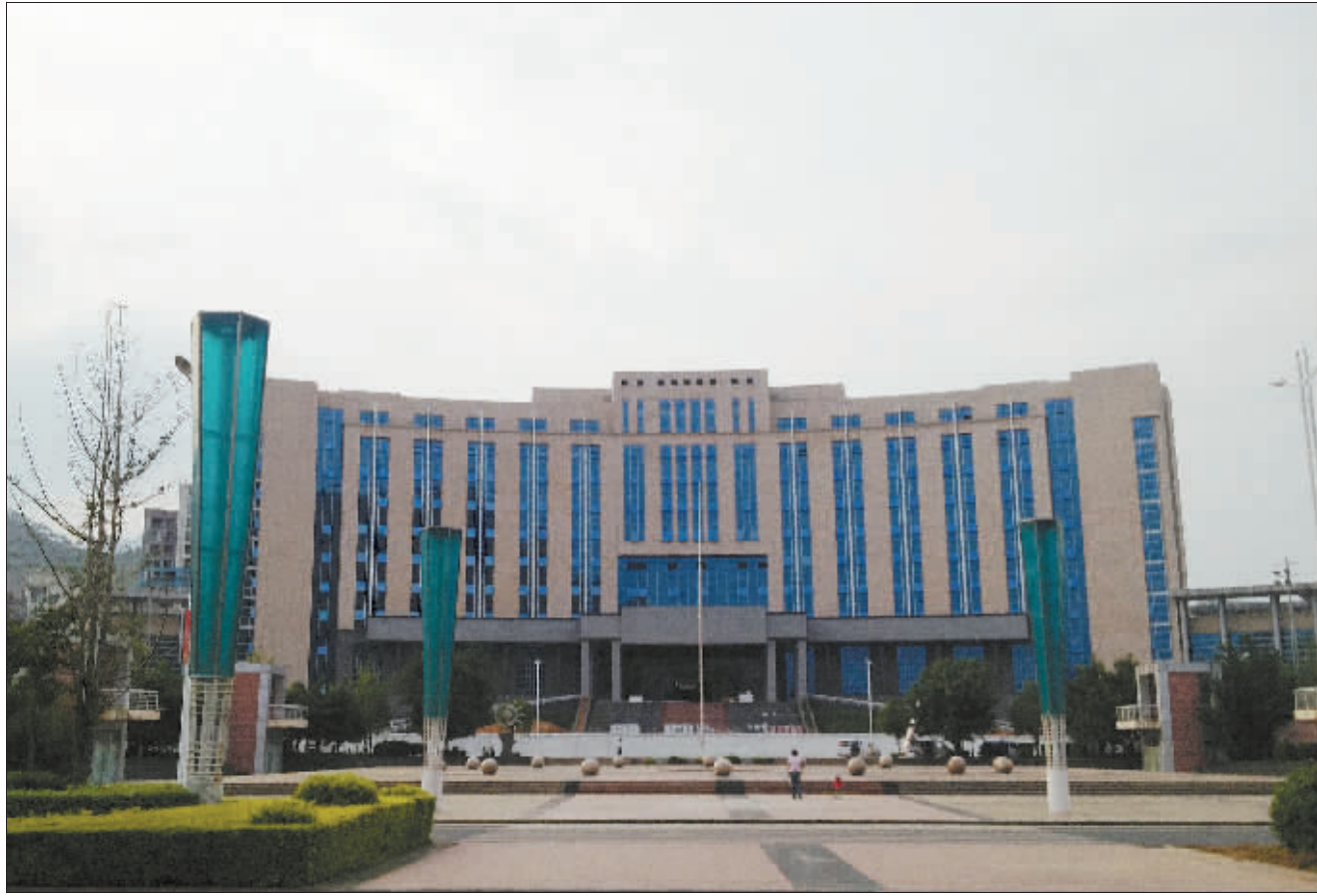
米易县仍在装修的新政府大楼,已空置多年。
