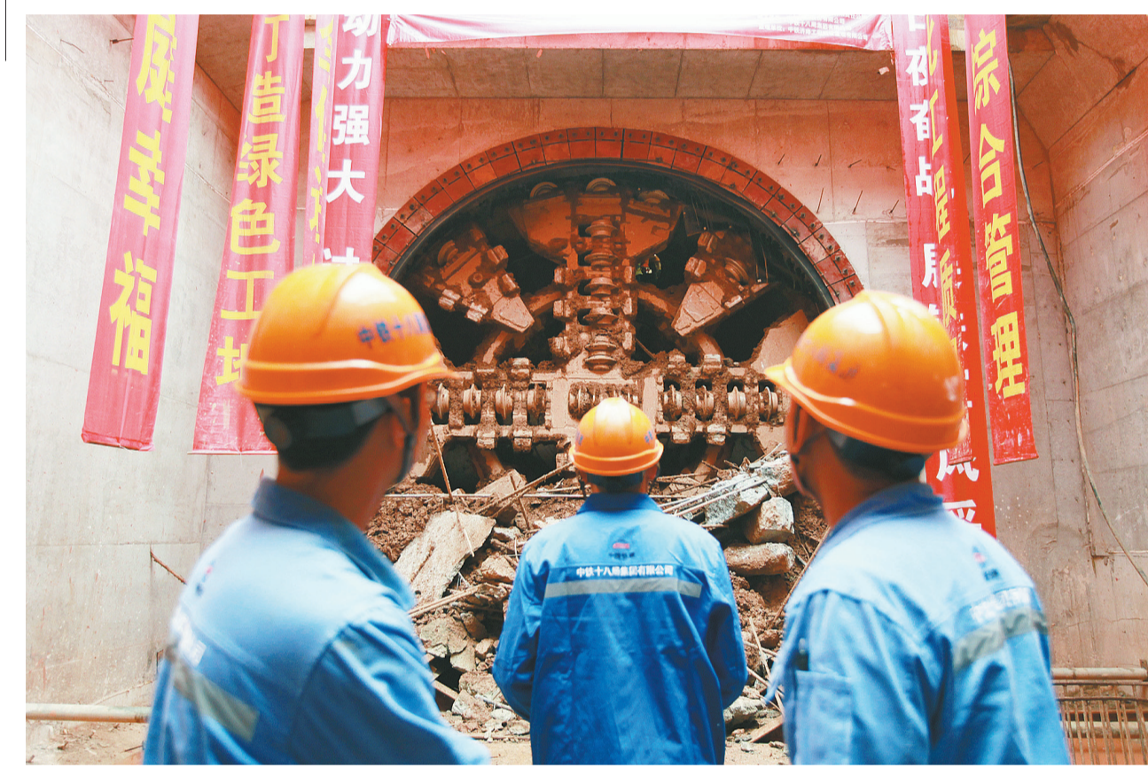
11月21日10时18分，伴随着一声破土巨响，南宁地铁2号线东延线首个盾构区间（那福路-玉岭路）顺利贯通。据中铁十八局集团市政工程有限公司广西管理部经理董瑞桥介绍，这次盾构掘进了175天，那玉区间的顺利贯通，标志着地铁2号线东延线项目取得了新的进展。南宁地铁2号线东延后将变成L字形，成为贯通南宁市南北向的骨干线，加强五象新区与旧城区的联系。中国青年报 中青在线记者 谢洋/摄
