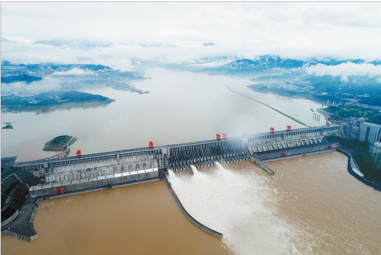
长江三峡枢纽开启泄洪深孔泄洪（7月2日摄，无人机照片）。受强降雨影响，长江上游干流、乌江及三峡区区间来水明显增加，2日10时三峡水库入库流量达50000立方米/秒。根据全国主要江河洪水编号规定，此次来水达到洪水编号标准，长江2020年第1号洪水 在长江上游形成。
