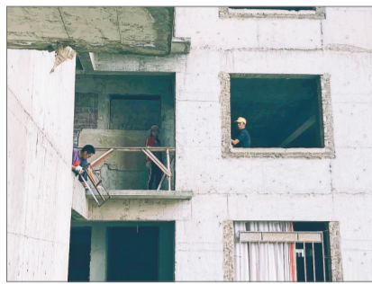
业主们自发维修烂尾楼。
