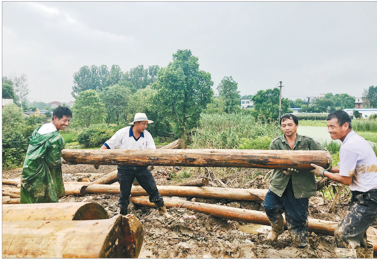
7月28日，同大圩南闸村段，当地村民在搬运用来加固圩堤的水杉木。
