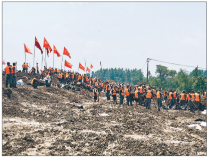
7月25日，同大圩南闸村，为了运输防汛物资，抗洪抢险人员正在平整泥路、铺设土石料。
