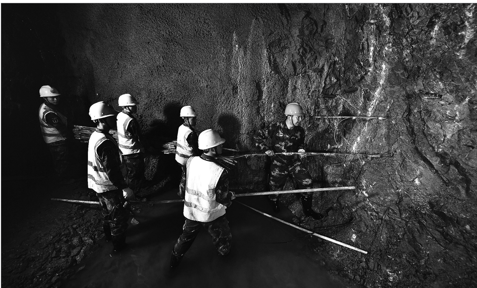
沙子呷（右一）带领官兵在爆破作业面装填炸药。
