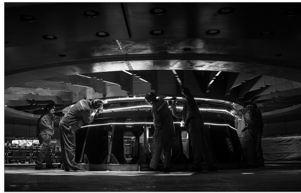
9月9日下午，位于四川宁南和云南巧家交界处金沙江干流的白鹤滩水电站，世界上单机容量最大的水发电机组转子开始吊装，中国能建葛洲坝集团机电公司的技术人员正在进行吊装前的准备工作。 汪龙华/摄
