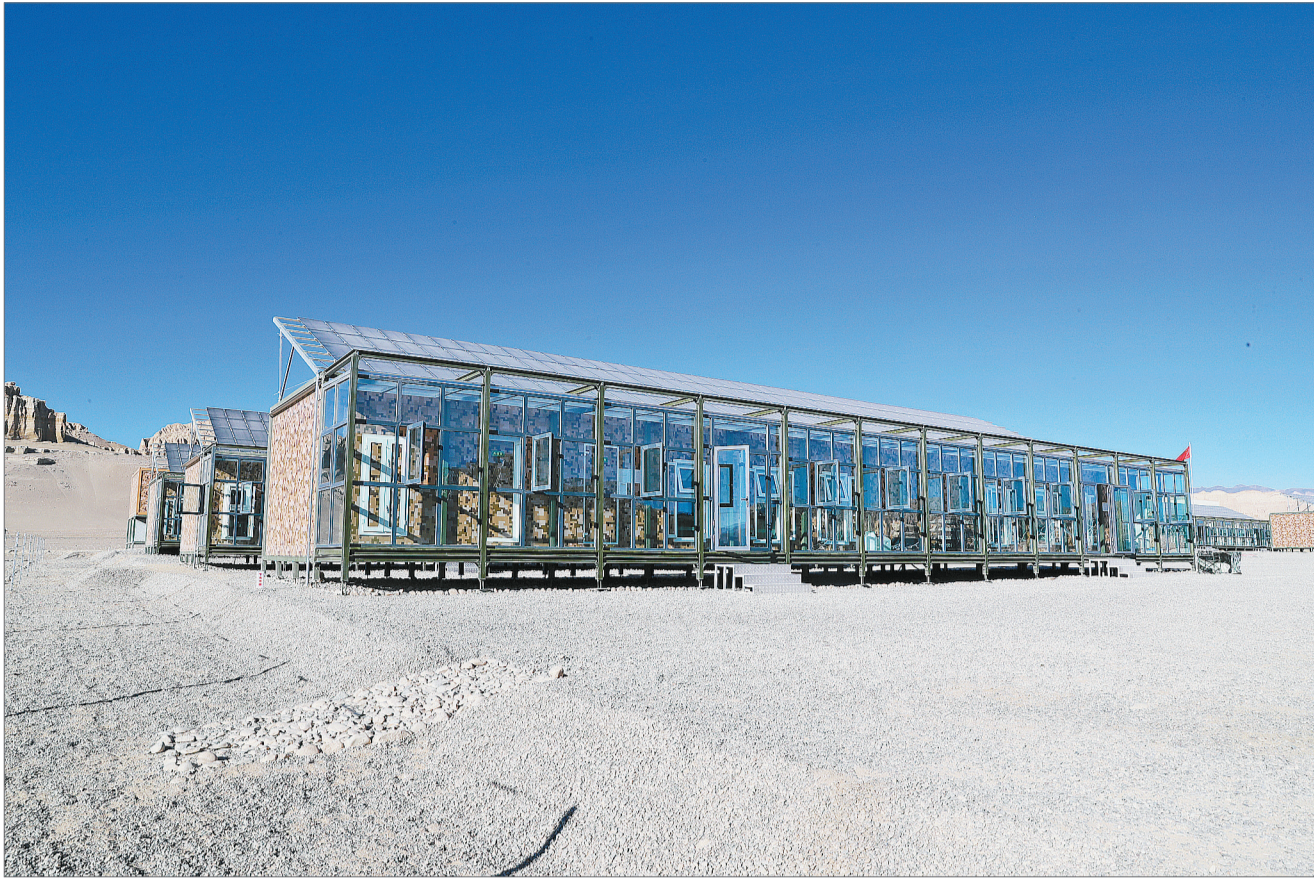
不久前,陆军某部官兵正式搬入新一代高原营房。新营房采用多项建筑新技术和新型建筑材料,能够更好地满足官兵日常生活、军事训练和战备执勤等需要。 杨涛/摄
