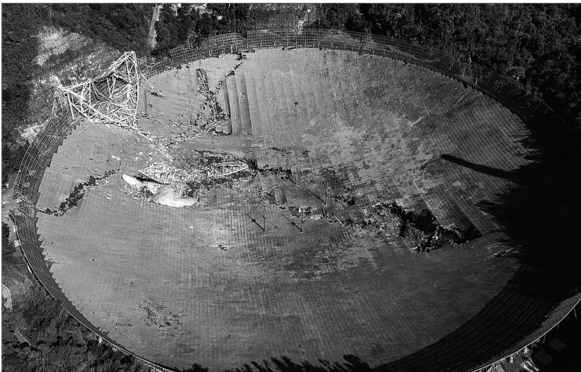
这是12月1日拍摄的位于美国海外属地波多黎各的阿雷西博望远镜。当地时间1日,阿雷西博望远镜因结构失控而坍塌。11月19日,美国国家科学基金会宣布阿雷西博望远镜将退役,并以可控方式拆除。但拆除计划尚在进行中,望远镜设备平台就已倒塌。新华社/法新
