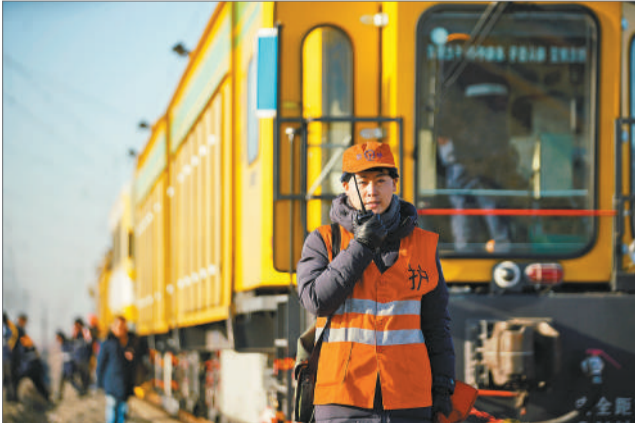
25岁的济南工务机械段防护员李红光用对讲机进行实时联控，以确保施工安全。 李校山/摄
