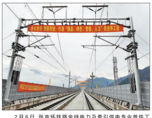
2月6日,张吉怀铁路全线电力及牵引供电专业首件工程评估圆满完成。图为接触网专业首件工程示范段。
