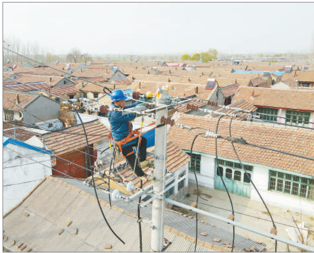
近日,国网山东武城县供电公司青年突击队,在10千伏礼仪线开展春季检修,为乡村经济可持续发展提供坚强的电力保障。 杨加明/摄
