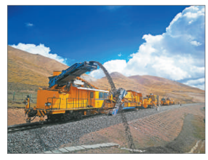
中国铁路青藏集团公司西宁工务机械段清筛第二车间在青藏铁路格拉萨站海拔4900米的布强格至唐古拉北区间进行大机线路清筛施工作业。王小清/摄
