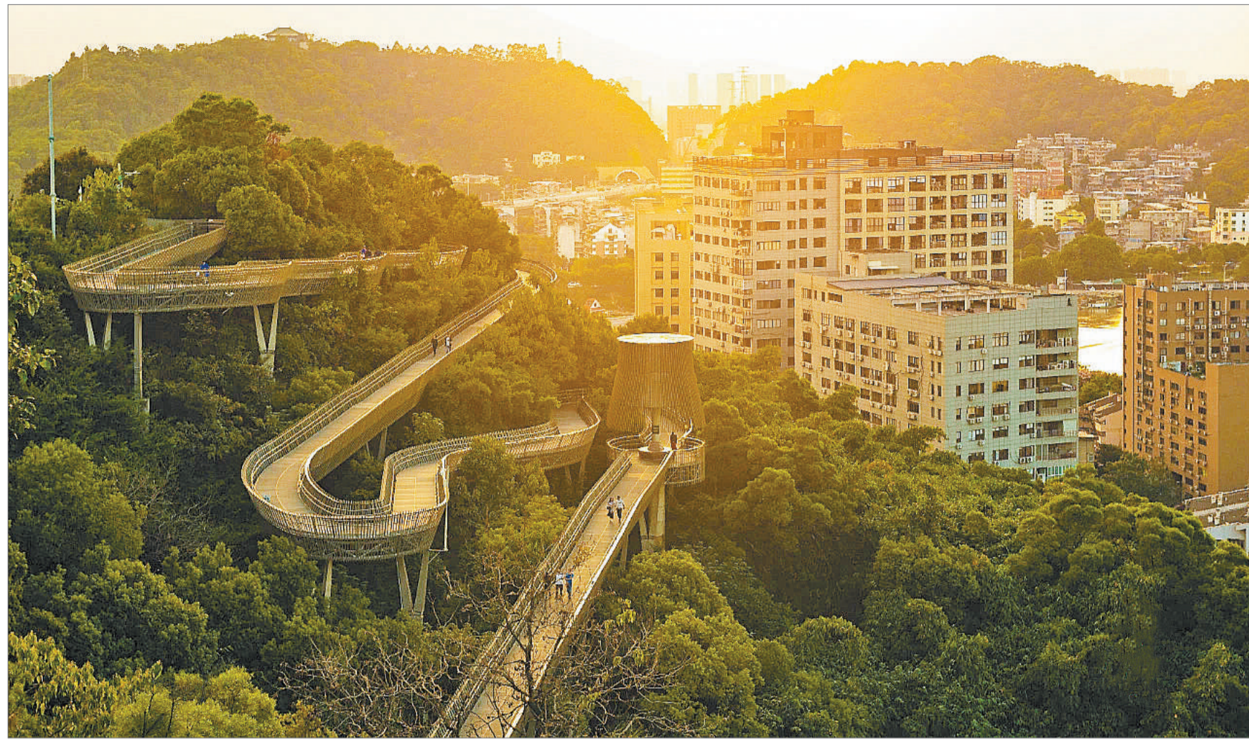
福州城市森林步道 福建,采用全国首创钢架镂空设计,主线全长6.3公里,环线总长约19公里,福道东北接左海公园,西南连闽江廊线,中间沿着金牛山山脊线,贯穿5个公园。 福州市园林中心供图
