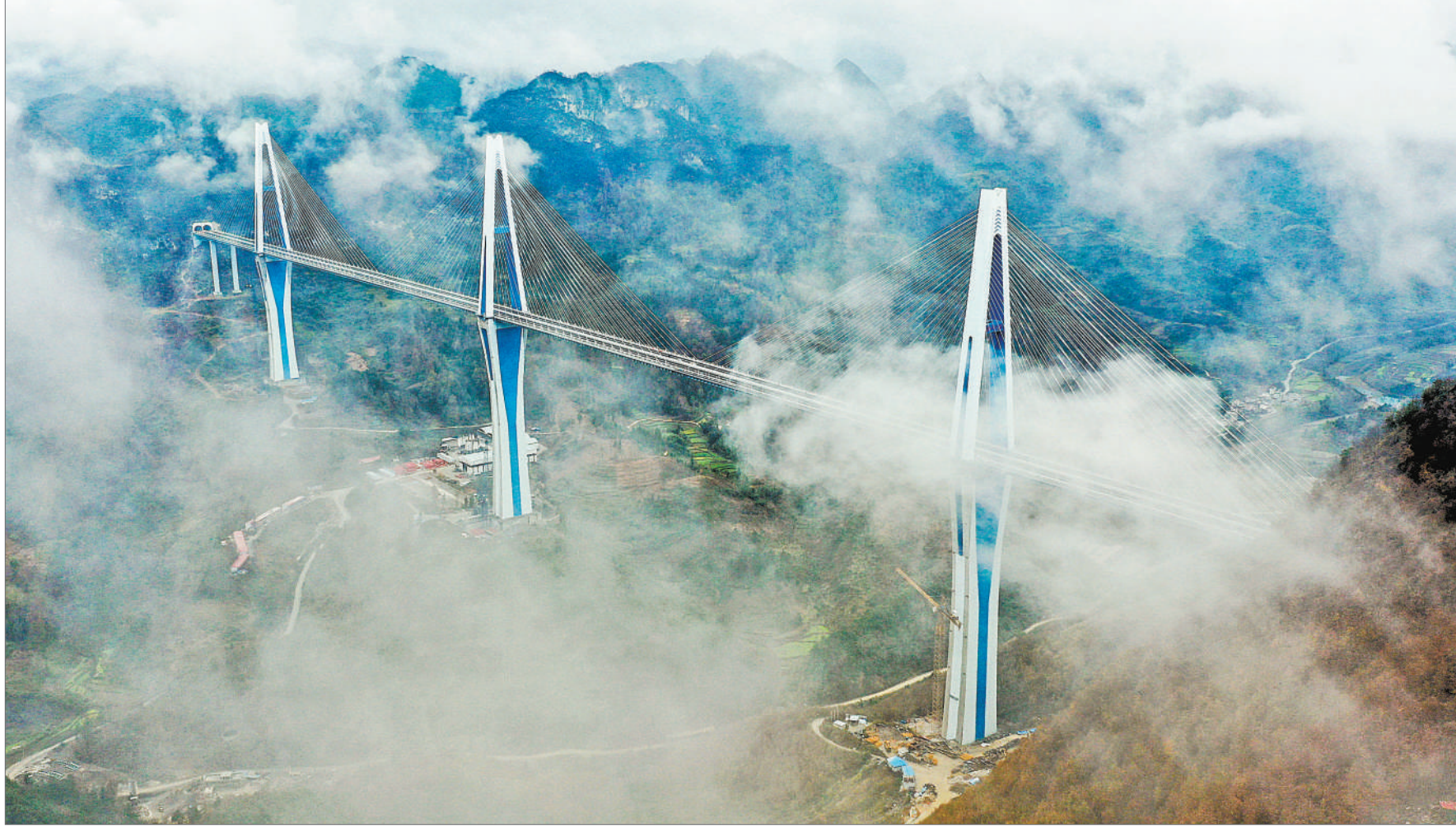
2019年12月30日，贵州黔南平塘县，航拍的平塘特大桥。当日，平塘特大桥建成通车。 视觉中国供图
