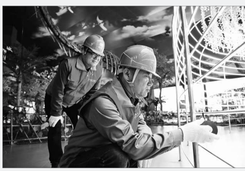
近日,结合党史学习教育,围绕“我为群众办实事”活动,国网诸城市供电公司组织团员青年青年进企业、进项目、进乡村、进农户,为群众纾难解困。图为该公司团员青年到林家村镇生态景区游客中心开展用电检查。
