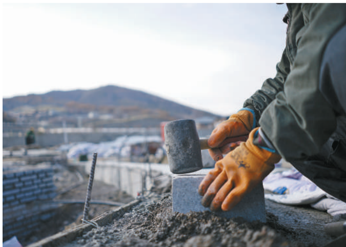
10月28日,河北省张家口市崇礼区,通往太子城国际会议中心的道路旁,一名工人正在砌砖。这里建起了一座“冰雪会堂”,冬奥会期间可容纳2500人参会。 中青报 中青网记者 李强/摄
