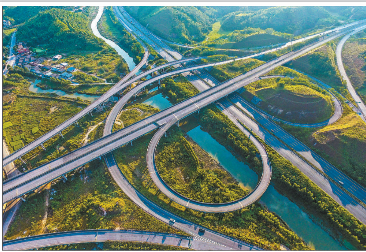
北投集团 建管养 一体化的东兴 防城高速互通式立交桥
