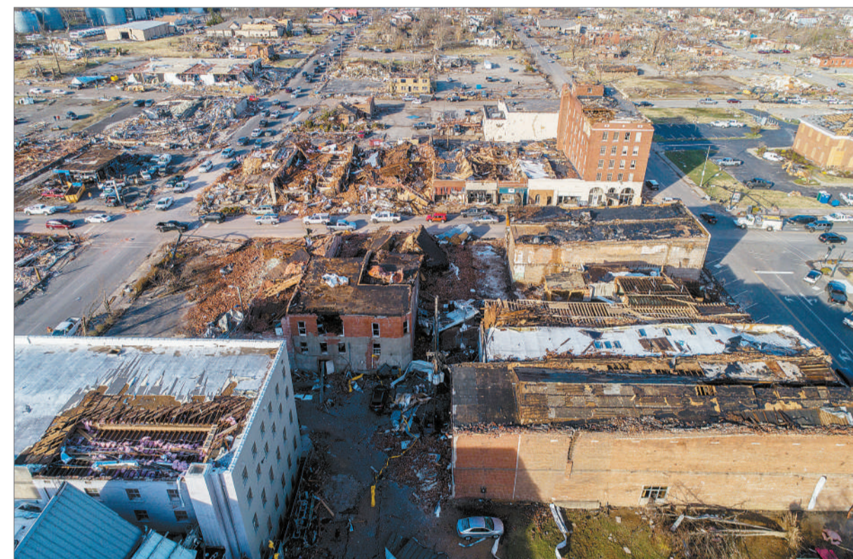
12月11日,美国肯塔基州梅菲尔德的房屋在龙卷风袭击中被毁(无人照片)。美国中部6个州10日夜间遭遇至少30场龙卷风袭击,已造成80多人死亡。新华社/美联
