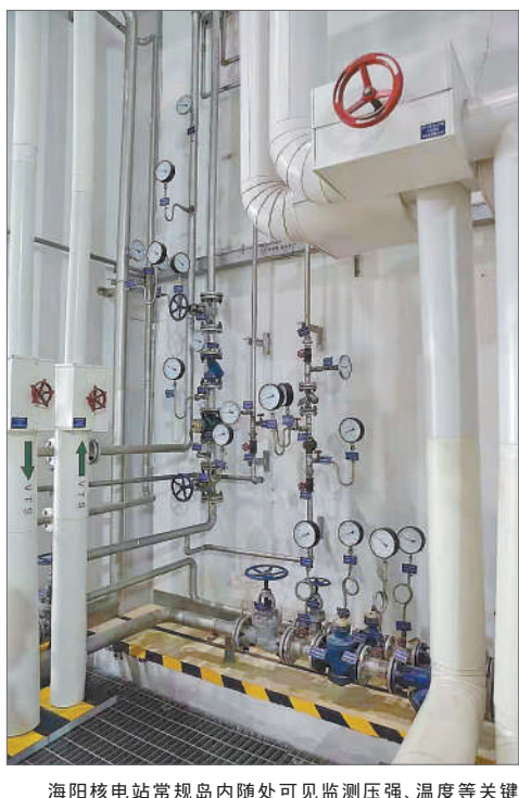
海阳核电站常规岛内随处可见监测压强、温度等关键性指标的设备。
