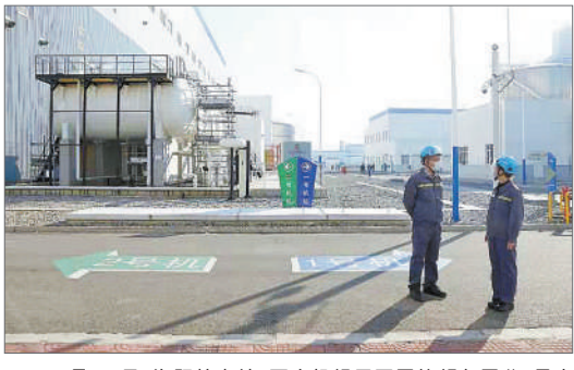
11月24日,海阳核电站,两个机组用不同的颜色区分,最大程度避免操作失误。
