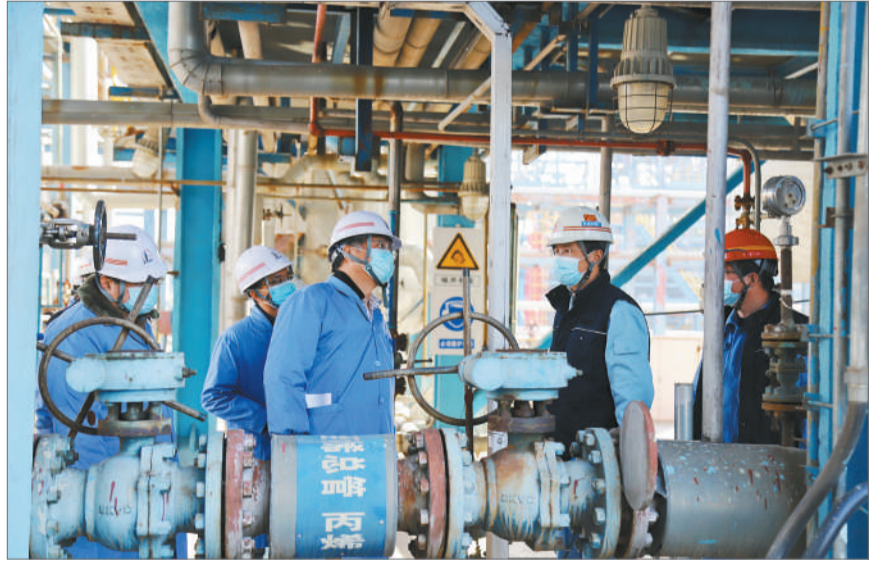
督导检查工作组正在检查。
