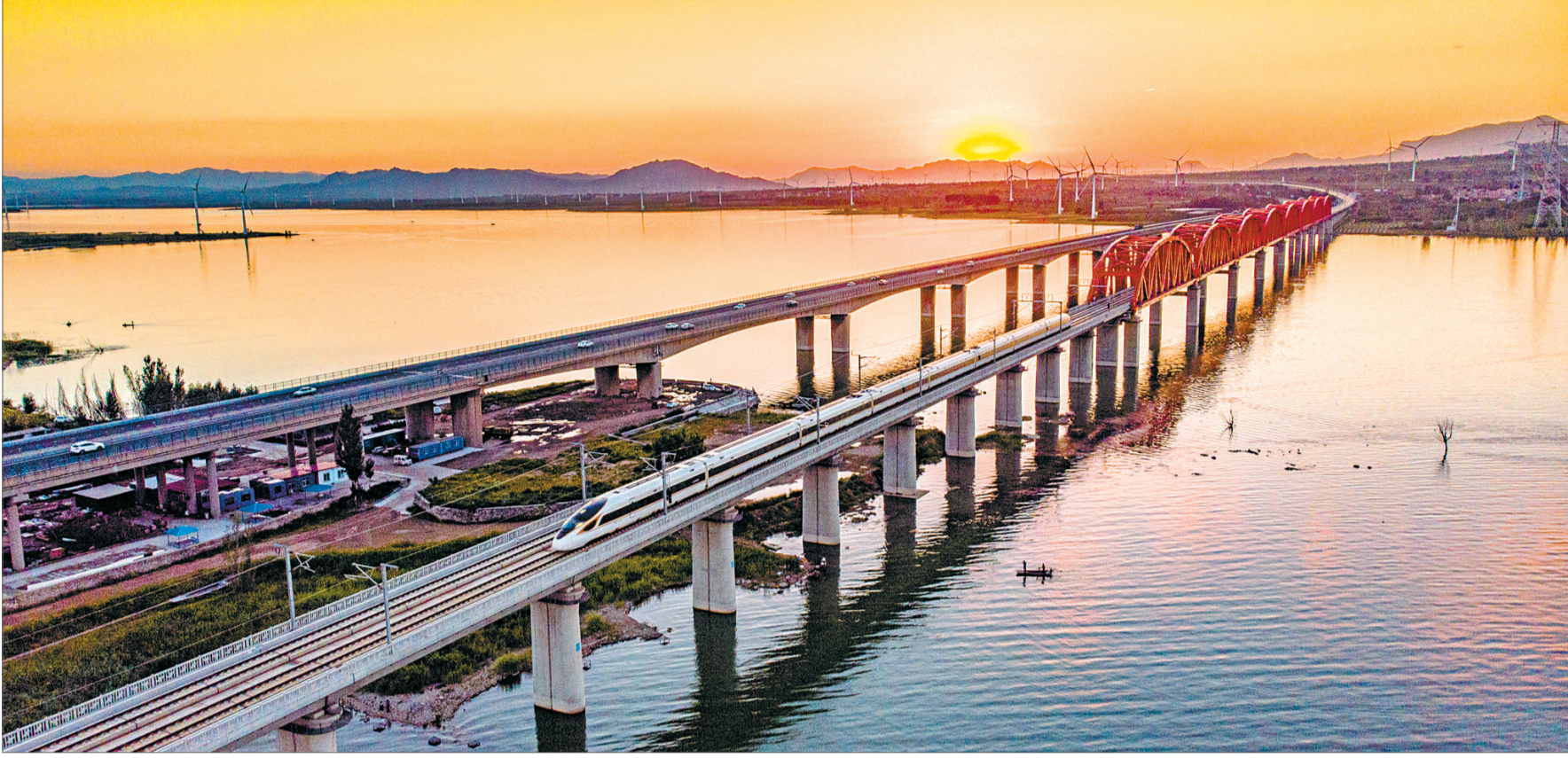
朝阳中,京张高铁复兴号智能动车组从官厅水库特大桥飞驰而过。
