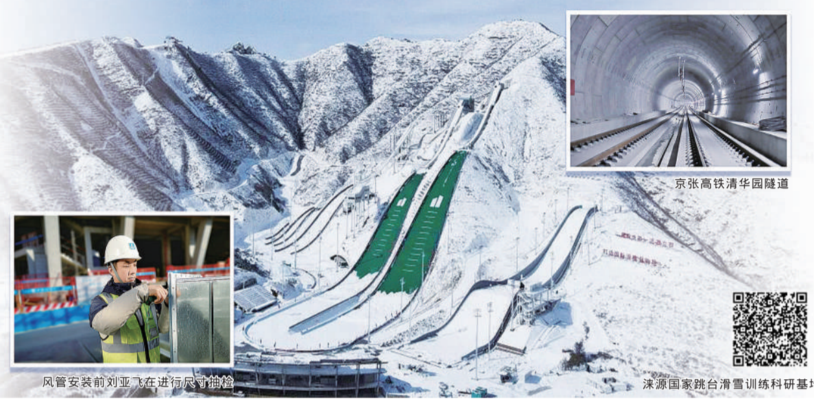
京张高铁清华园隧道 涿源国家跳台滑雪训练科研基地
