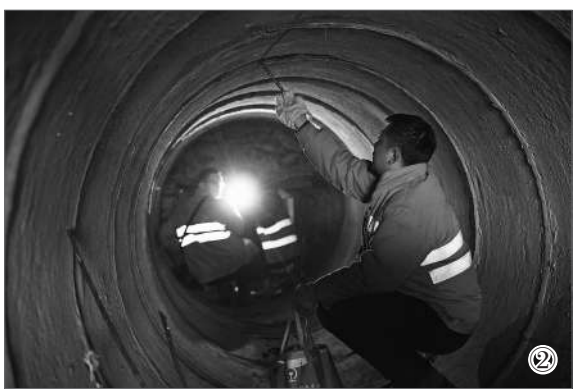
②2022年春运期间,萍乡工务段青年突击队对涵渠内剥落漏筋处进行油漆覆盖。 ③2月9日,在江西上饶开往广州东莞东的K4039次 青春号 共青团号临客列车上,志愿者在向小朋友们普及爱路护路小知识。
