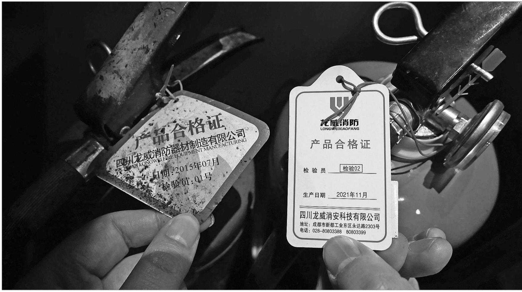
火锅店灭火器已过有效期。
