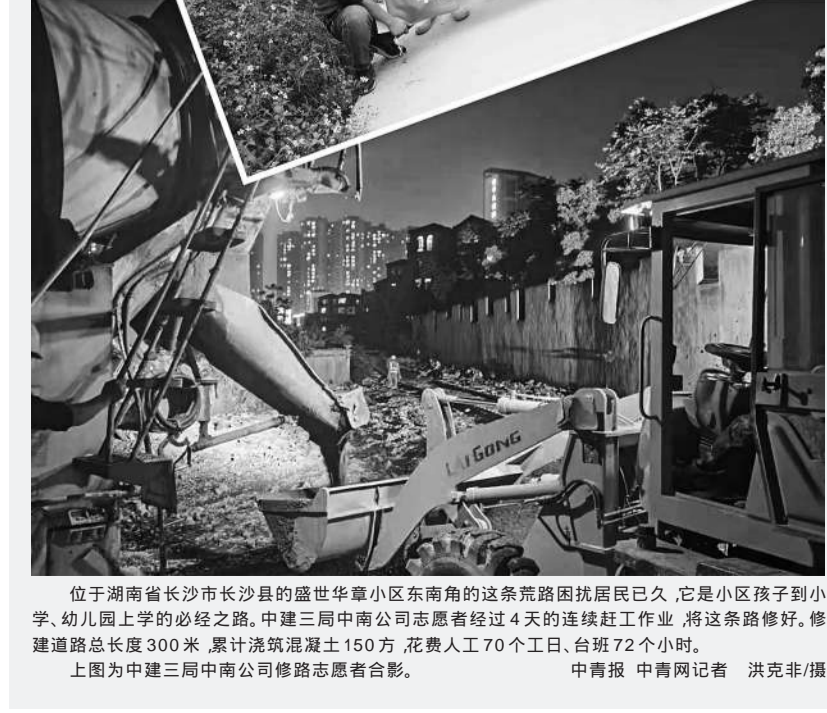
位于湖南省长沙市长沙县的盛世华庭小区东南角的这条荒路困扰居民已久，它是小区孩子到小学、幼儿园上学的必经之路。中建三局中南公司志愿者经过4天的连续赶工作业，将这条路修好。修建道路总长度300米，累计浇筑混凝土150方，花费人工70个工作日、台班72个小时。
