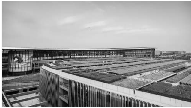
为探索机场绿色能源新模式,近日,大兴机场在停车楼投建的太阳能光伏发电项目顺利投用,成为大兴机场坚持绿色低碳理念、持续推进绿色机场建设的一项重要举措。
