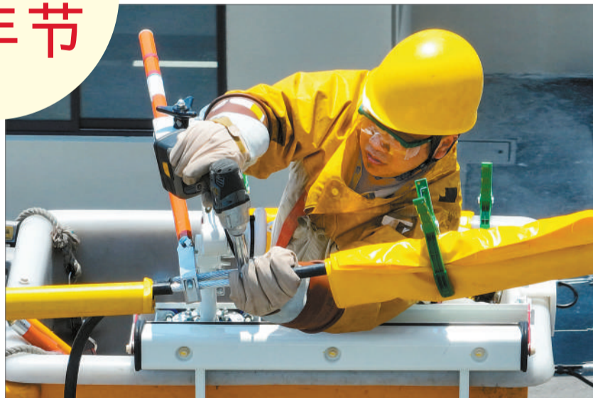
5月4日，电力青年员工进行技能比武，采用机械臂+人单人单新作业法拆搭支线引线。汤德宏/视觉中国
