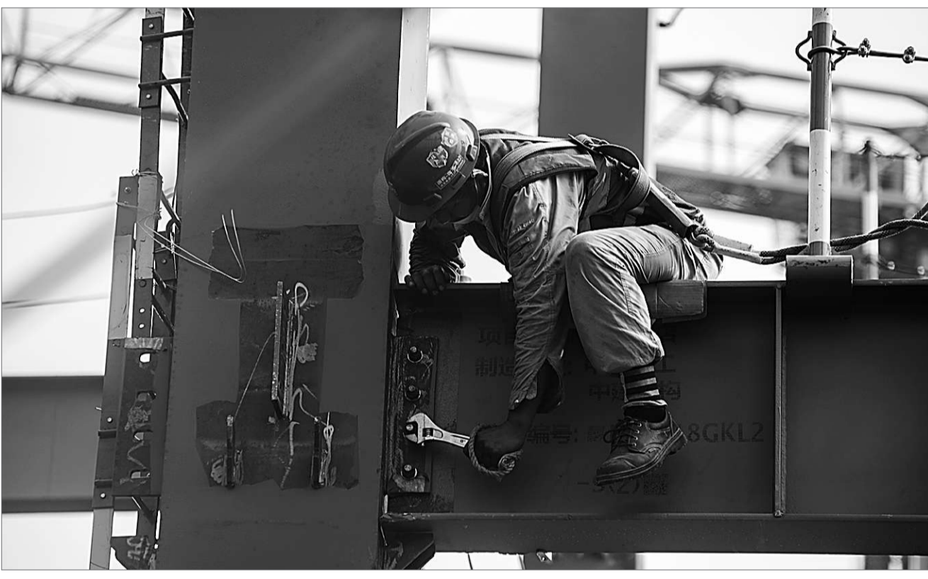
2021年9月,在中建科工承建的深圳湾区会展国际酒店项目现场,工人正在进行钢结构安装施工。
