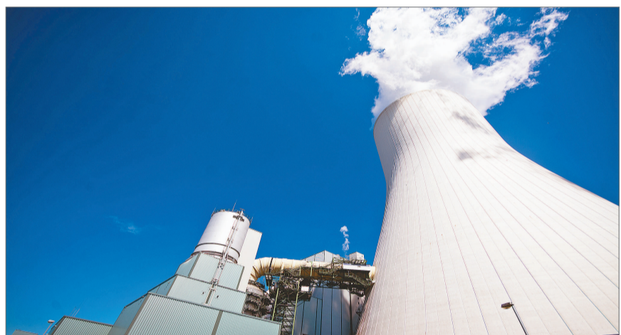
当地时间6月22日的德国杜伊斯堡Walsum燃煤发电厂景象。面对天然气供应不足的问题,德国计划使用煤炭代替天然气发电。视觉中国供图
