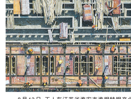
8月13日,工人在江苏省淮安市淮钢特钢产业园建筑工地忙碌。视觉中国供图
