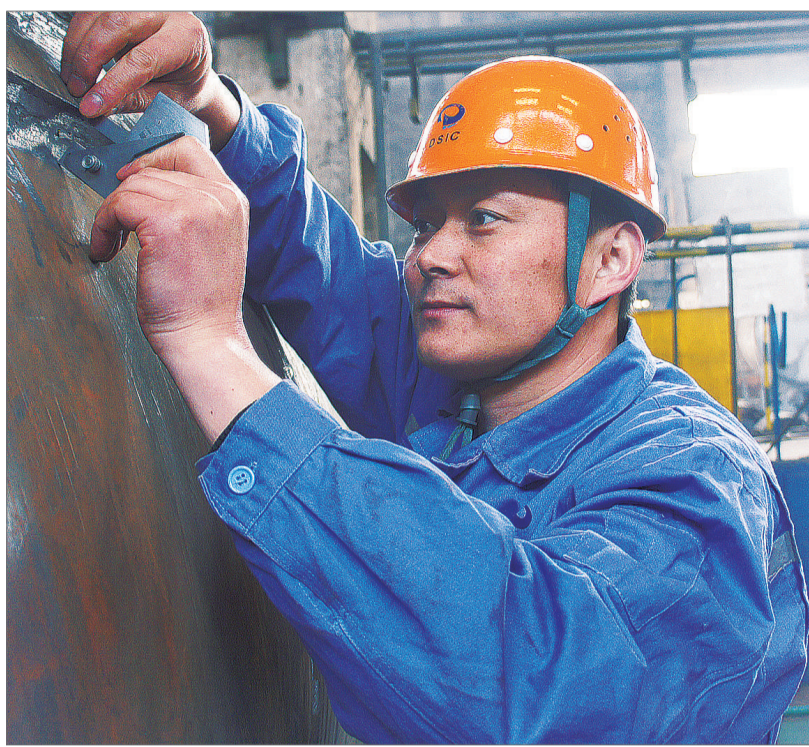
左：朱先波正在检测焊脚尺寸。右：朱先波正在大连市技师学院讲解双相不锈钢焊接技术。
