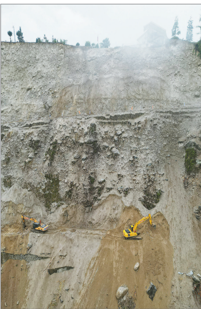
9月9日，四川泸定，抢险人员驾驶挖掘机在绝壁上抢修磨西镇前往海螺沟景区的道路。这条路一面是磨西镇，一面是山体，因地震完全中断，经过3天的抢险，至海螺沟大桥的路段即将抢通。（无人相机照片）张浪/摄 视觉中国供图
