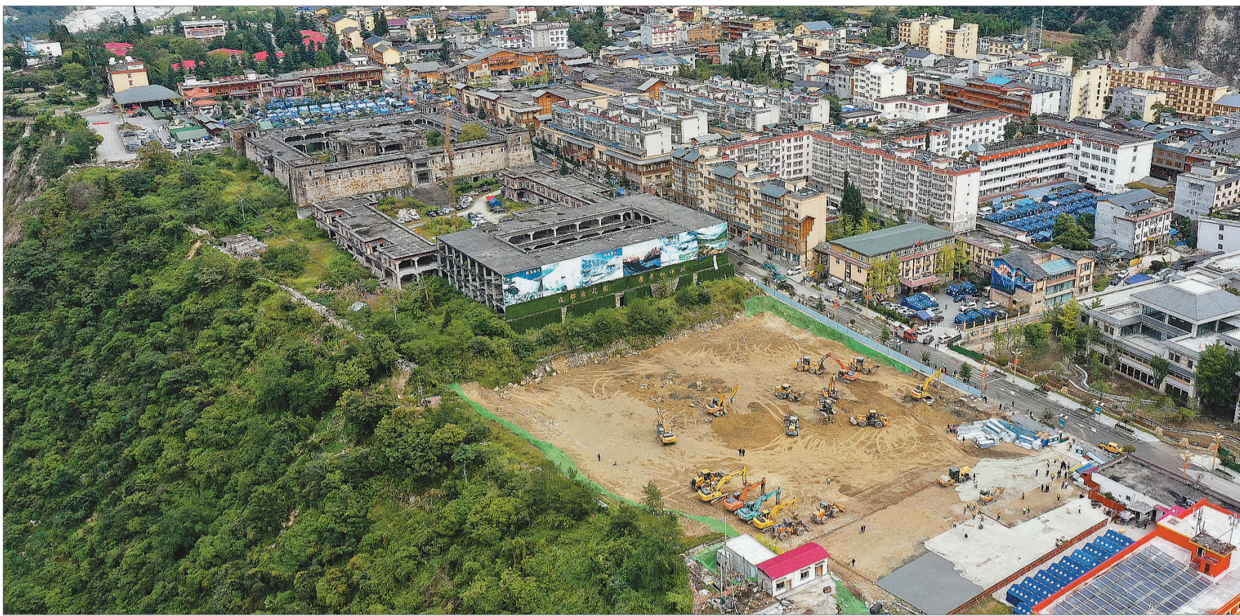
9月12日 四川甘孜，位于贡嘎大道中段的泸定县磨西镇首个地震过渡安置房小区建设现场。
