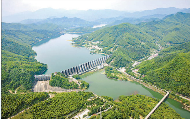
淮河治理过程中修建的佛子岭水库。水利部淮河水利委员会供图
