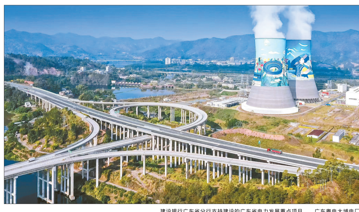
建设银行广东省分行支持建设的广东省电力发展重点项目 广东粤电大埔电厂
