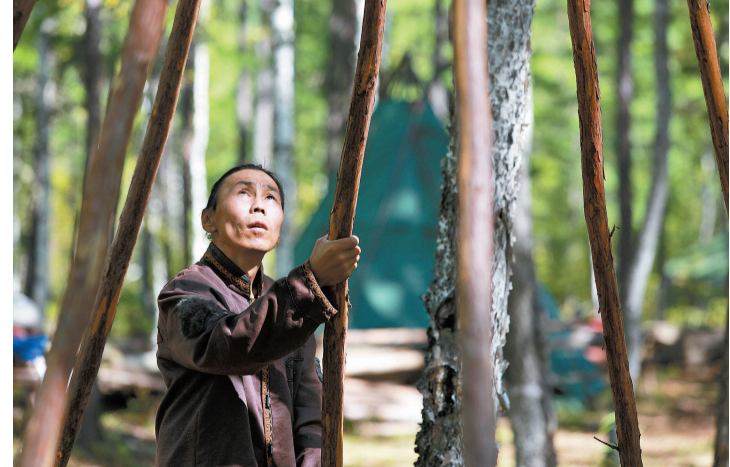
2018年7月10日，内蒙古大兴安岭林区，猎民索国光在大兴安岭腹地搭建使鹿鄂温克人的传统居所撮罗子。撮罗子利用大兴安岭林区中特有的小杆(松树的枝干)作为原材料搭建，外表呈圆锥形，高约3米，直径约4米。
