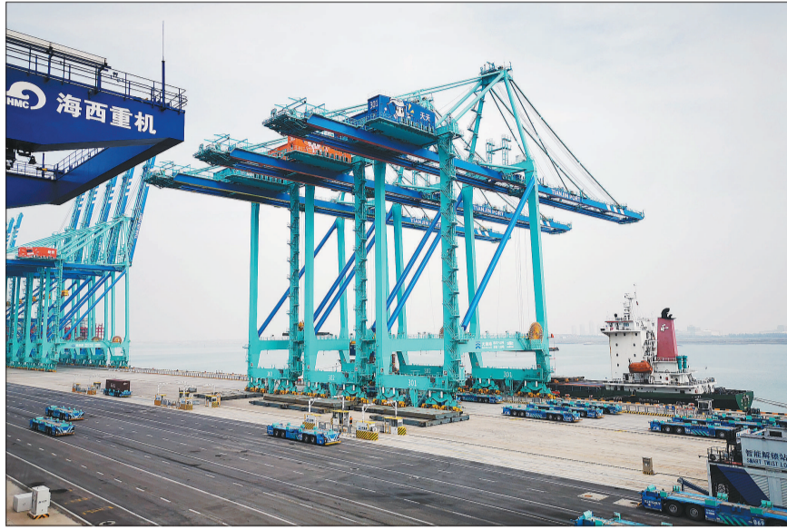
天津港智慧码头作业现场。
