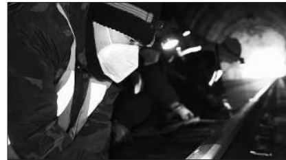
冬日的早晨,太原铁路大同工务段王家湾线路车间维修队青年在进行线路整修作业。
