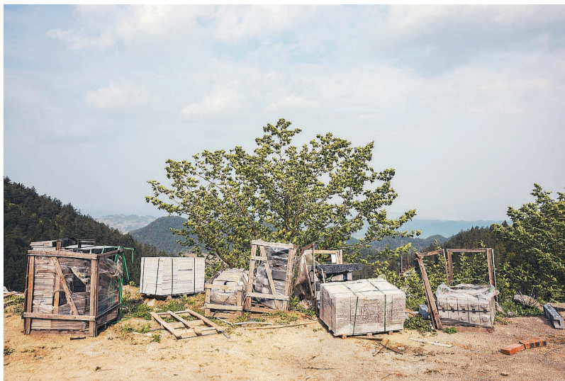
4月2日,万福山生态陵园,一些建筑材料摆放在路边。这处陵园于2016年开工建设,规划墓位约1万个,目前正在沿着山势开发更多的地块。
