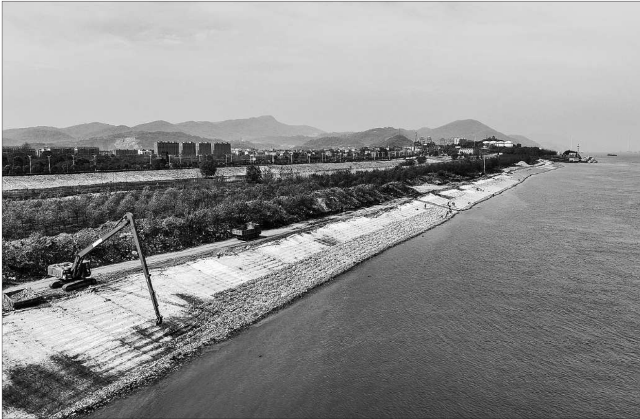
2022年4月4日，江西省九江市瑞昌市码头镇，施工单位在长江江西瑞昌段梁公堤进行长江干流崩岸应急治理工程作业。
