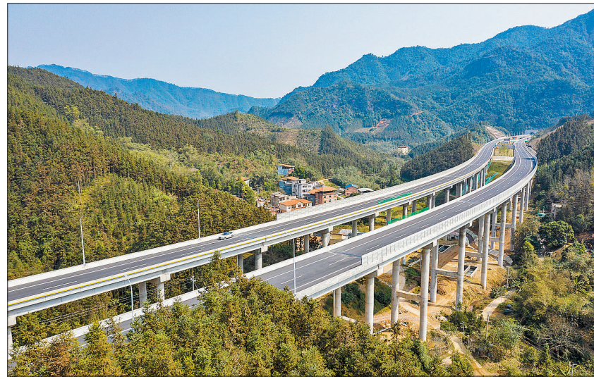
近日，广西平南至武宣高速公路建成通车，构建起桂中地区通往粤港澳大湾区的又一条经济动脉。该项目由中建路桥集团承建，主线全长63.7公里，设计行车时速120公里。施工过程中，各项目部成立青年突击队，设立青年先锋岗，引领青年员工攻坚克难、建功立业，有力推进了工程建设进度。
