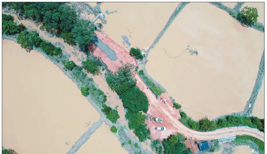
6月11日，在广西合浦县白沙镇，工人在施工修复遭洪水损毁的堤坝（无人机照片）。近日，受强降雨持续影响，广西合浦县多个乡镇遭遇洪灾。目前，洪水逐渐消退，当地有关部门正开展灾后重建，尽快恢复群众生产生活。
