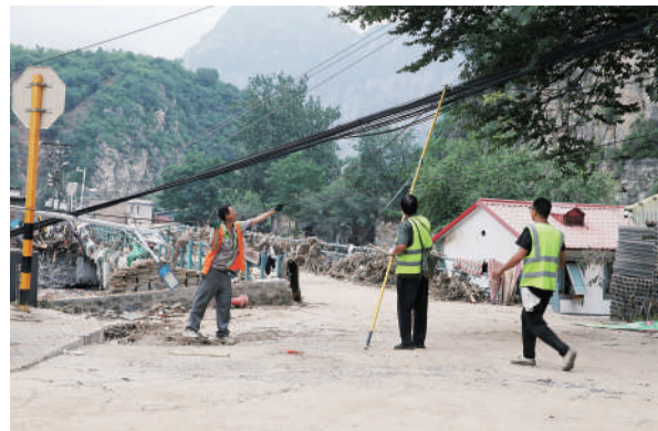
8月6日,北京市门头沟区妙峰山镇担礼村,来自某网络公司的维修人员正在整理修复当地被洪水损坏的网络线路。 中青报·中青网记者 陈剑/摄
