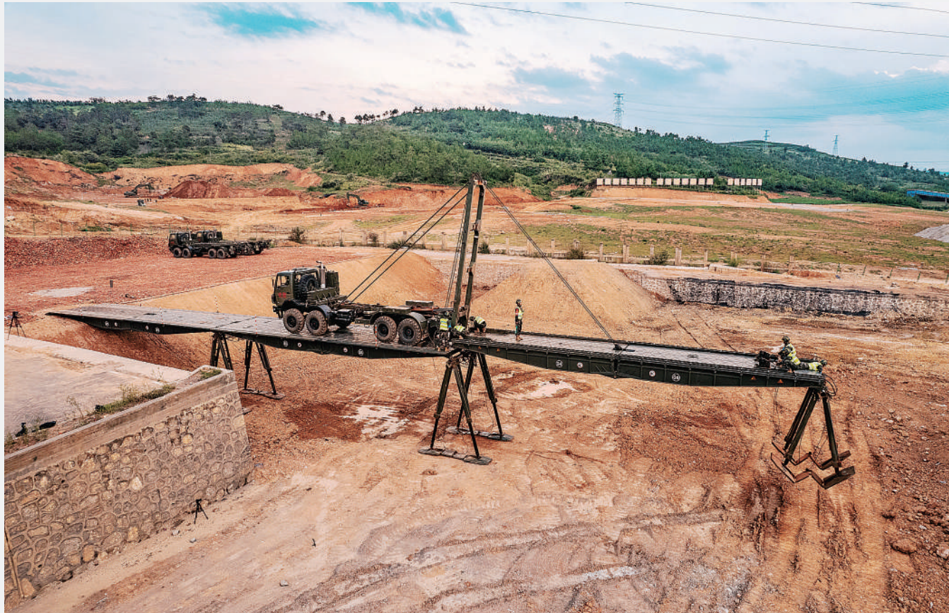
近日，武警第二机动总队某支队以桥梁被洪水冲毁为背景，展开了一场桥梁快速抢通演练，进一步提高官兵在公路交通突发灾害中的应急处置能力。图为官兵架设新型应急模块化桥。
