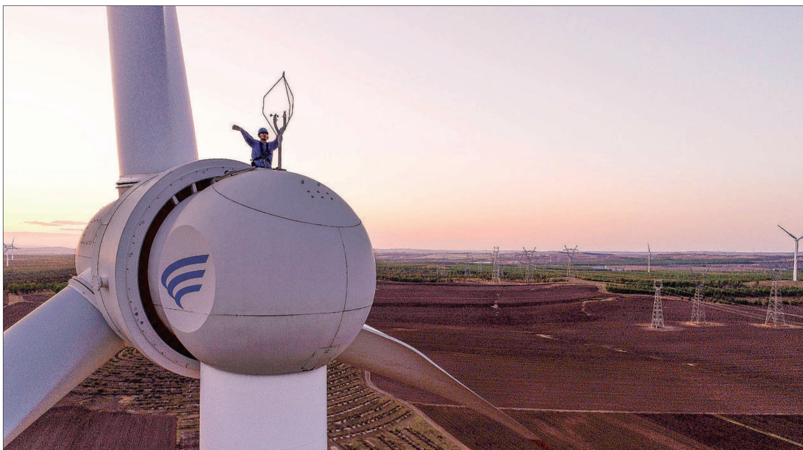
5月23日,内蒙古兴安盟,工人在乌兰浩特市呼和马场风电光伏场检修设备。
