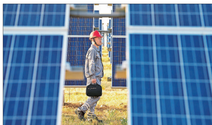
5月23日,内蒙古兴安盟,工人在乌兰浩特市呼和马场风电光伏场巡查。
