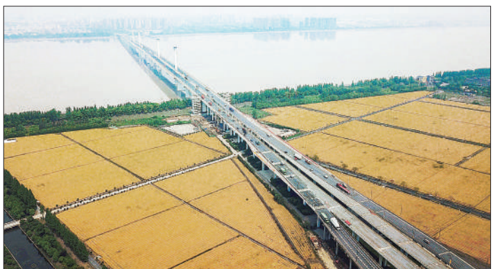
如何在办会期间保障交通的畅通和有序，是亚运会东道主最为关注的核心问题之一。除了办会时建设亚运专用交通指挥调度平台，统筹调度各人员与车辆外，从去年开始，服务于亚运会的各项精品交通工程就已陆续动工建设。图为杭州江东大道提升改造工程。
