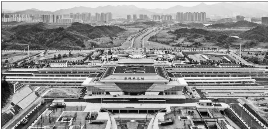
作为昌景黄高铁中重要的一环,新建景德镇北站是其全线唯一的既有有线施工车站,总建筑面积1.66万平方米,建筑高度28.35米,站场规模5台13线,被誉为“千年瓷都新名片”。
