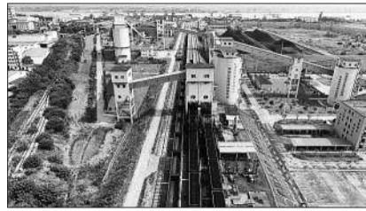
位于江西省煤炭储备中心的铁路专用线正在进行电煤装车作业。代建力/摄
