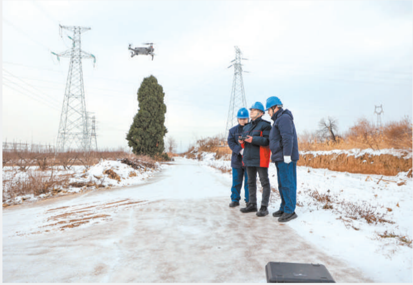
12月15日，山西运城，国网平陆县供电公司人员利用无人机对供电线路进行巡视。视觉中心供图
