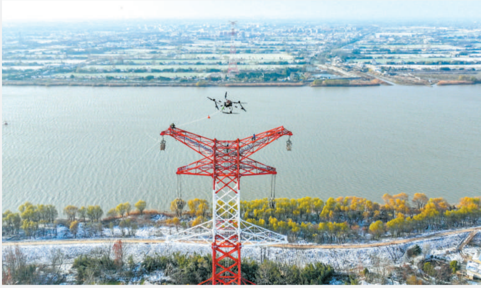
12月16日，在江苏扬州—镇江±200千伏直流输电线路工程夹江大跨越现场，江苏省送变电有限公司施工人员操作无人机架设电网。视觉中心供图
