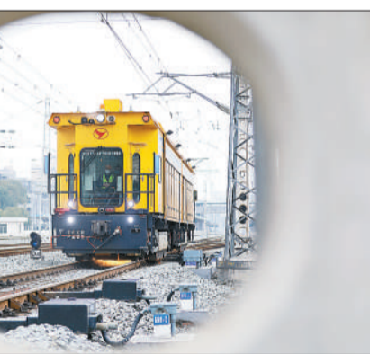
为确保2024年春运行车安全,中国铁路西安局启动董家湾铁路集中修作业,图为安康工务段正在使用道岔打磨车进行打磨作业。
