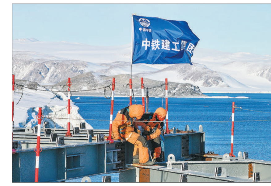
中铁建工集团建设者在进行秦岭站主楼钢构安装。 郑迪/摄
